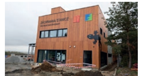
Hlavní budova, vstup
