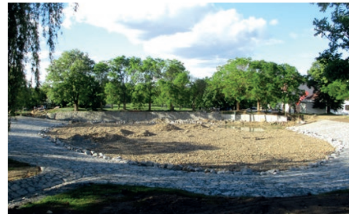
Stav rekonstrukce Ohrady v létě 2020
