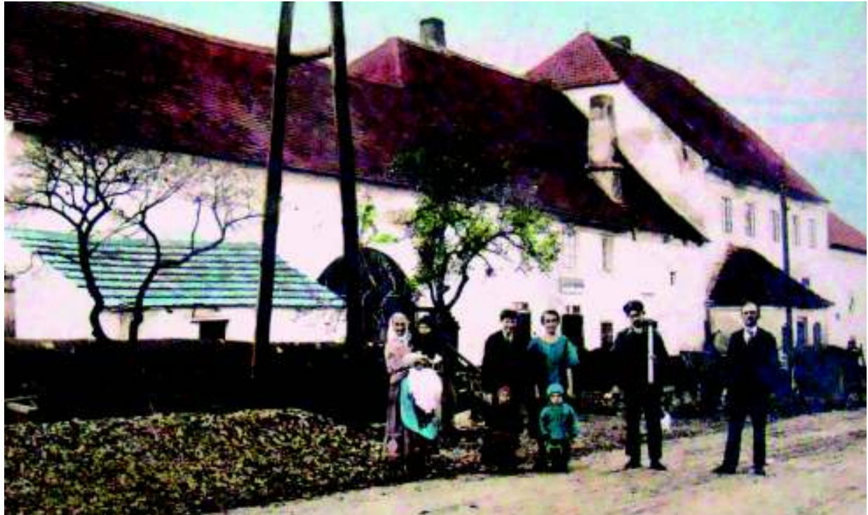
Betáňská kovárna Aloise Vágnera z počátku 20. století, vyšší budova v pozadí je betáňská hospoda (archiv paní Pubrdlové).
