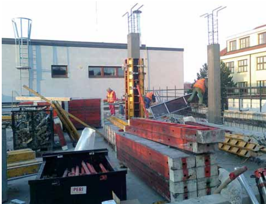
Stavební práce v ZŠ Kunratice (foto Ing. Alinčová).
