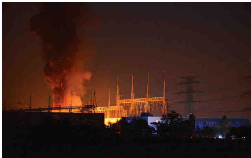
Noční požár trafostanice 18. června (foto P- Hilmarová).
