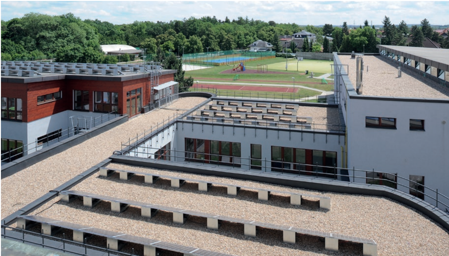
Solární panely na základní škole instalované v roce 2010
