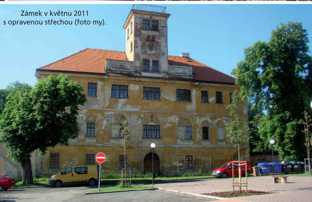
Statek se zámek v zimě 2004 před rekonstrukcí areálu (foto Irstav).
