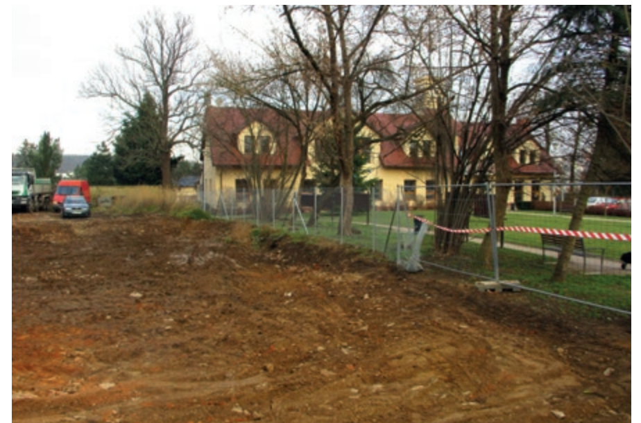
Průběh výstavby nového areálu
