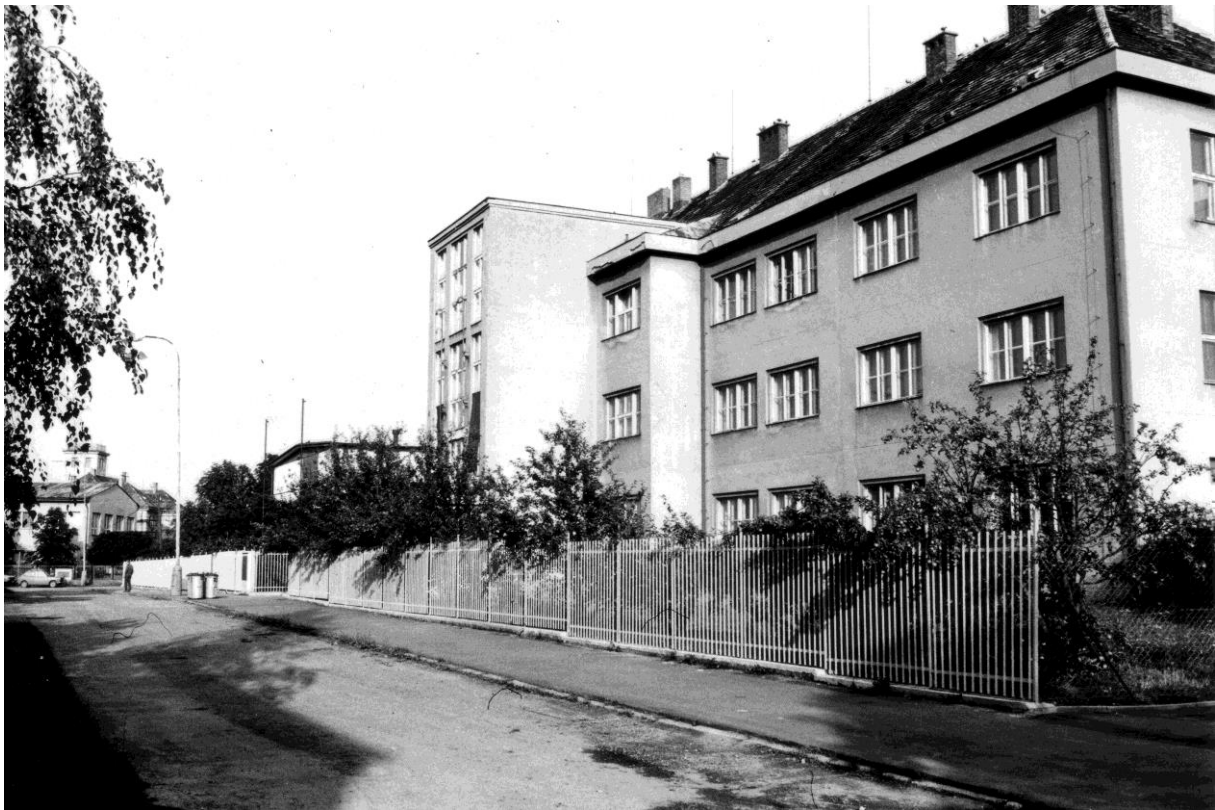
Masarykova měšťanská škola - po přestavbě
